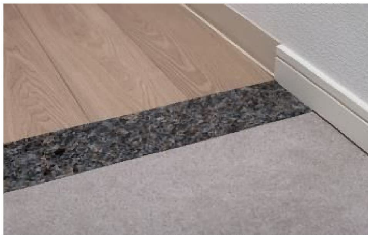
段差のないバリアフリー
